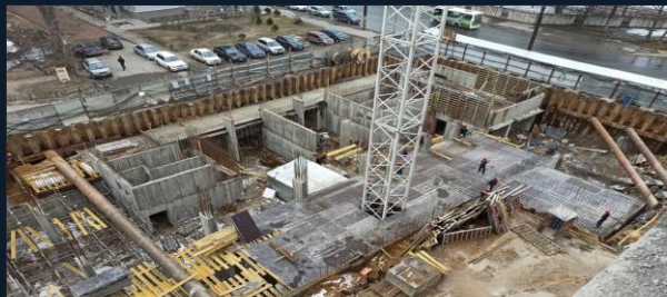
Фундаменты и котлованы
